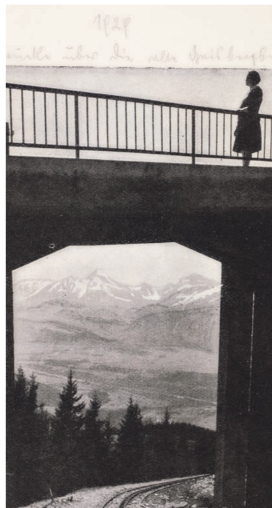
Straßenbrücke über die stillgelegte Gaisbergbahnstrecke, 1929. Druck auf Papier © Salzburg Museum
